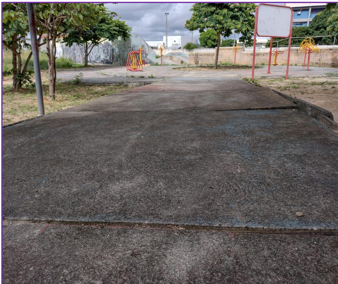
Figura 5. Piso de acesso à praça
